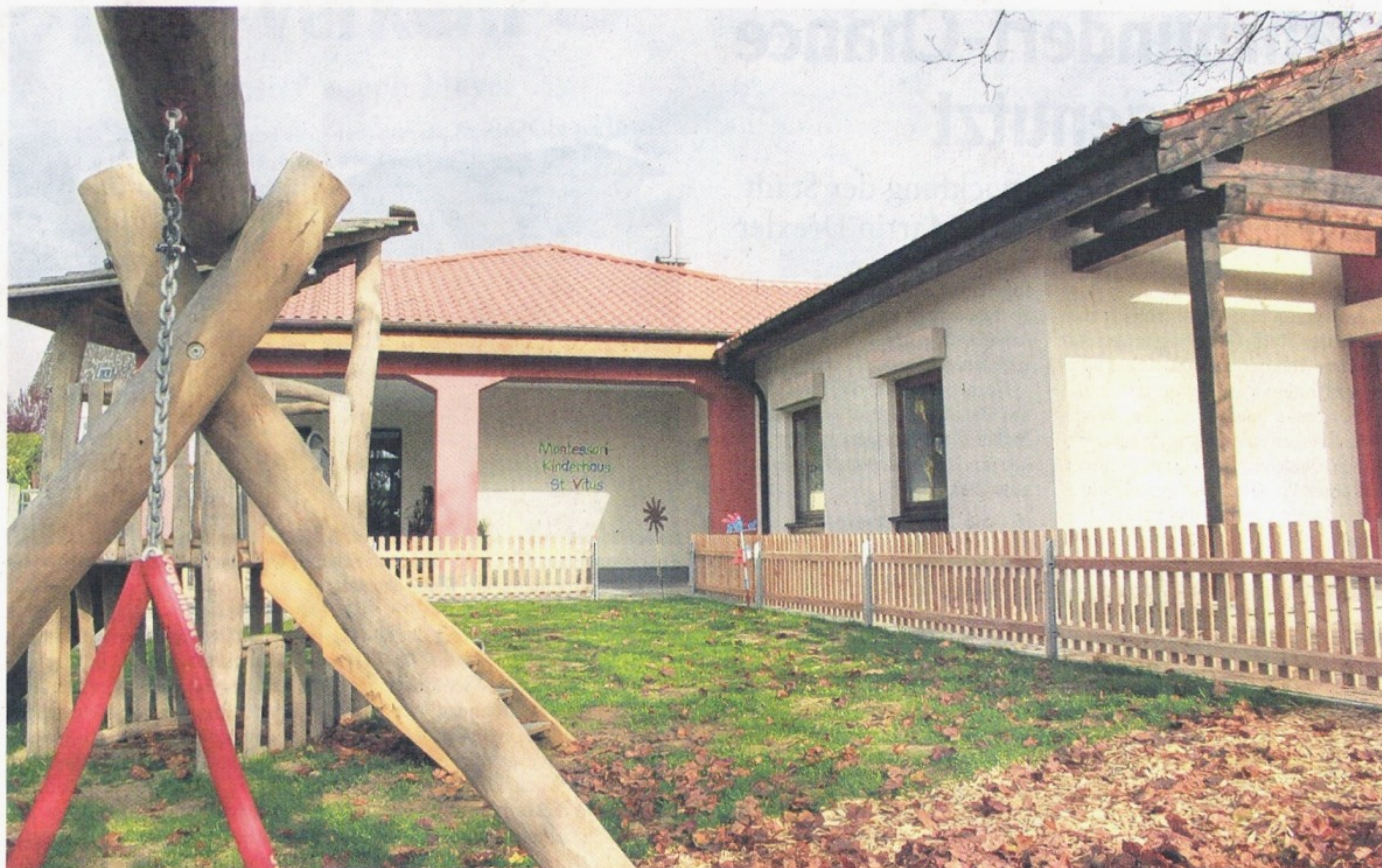
Die Gemeinde Amerdingen hatte heuer illen Grund zur Freude: Dort wurde nämlich die neue Kinderkrippe in Betrieb genommen. Das Gebäude mit 15 Plätzen wurde an den bestehenden Kindergarten angebaut.
